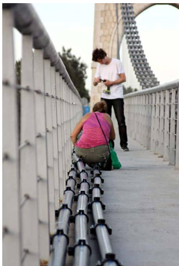
Arribada de material i muntatge de ramals i collarins
