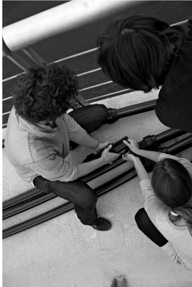
Connectant tubs de polietilè.
